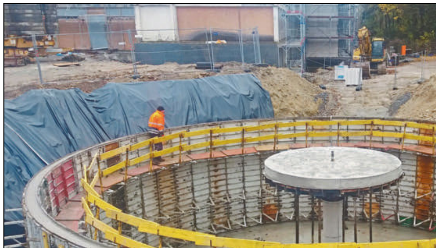
Der Eisspeicher Klima Campus Lichtenau ist mittlerweile fertig gestellt.
