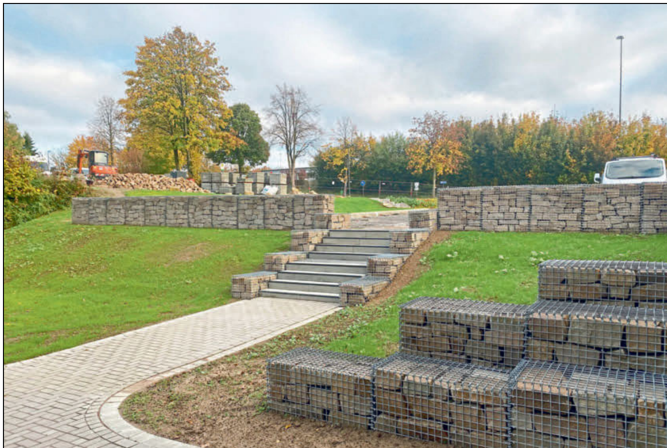
Die Arbeiten am Klima-Campus schreiten voran, auch die Außenbereiche werden neu gestaltet.
